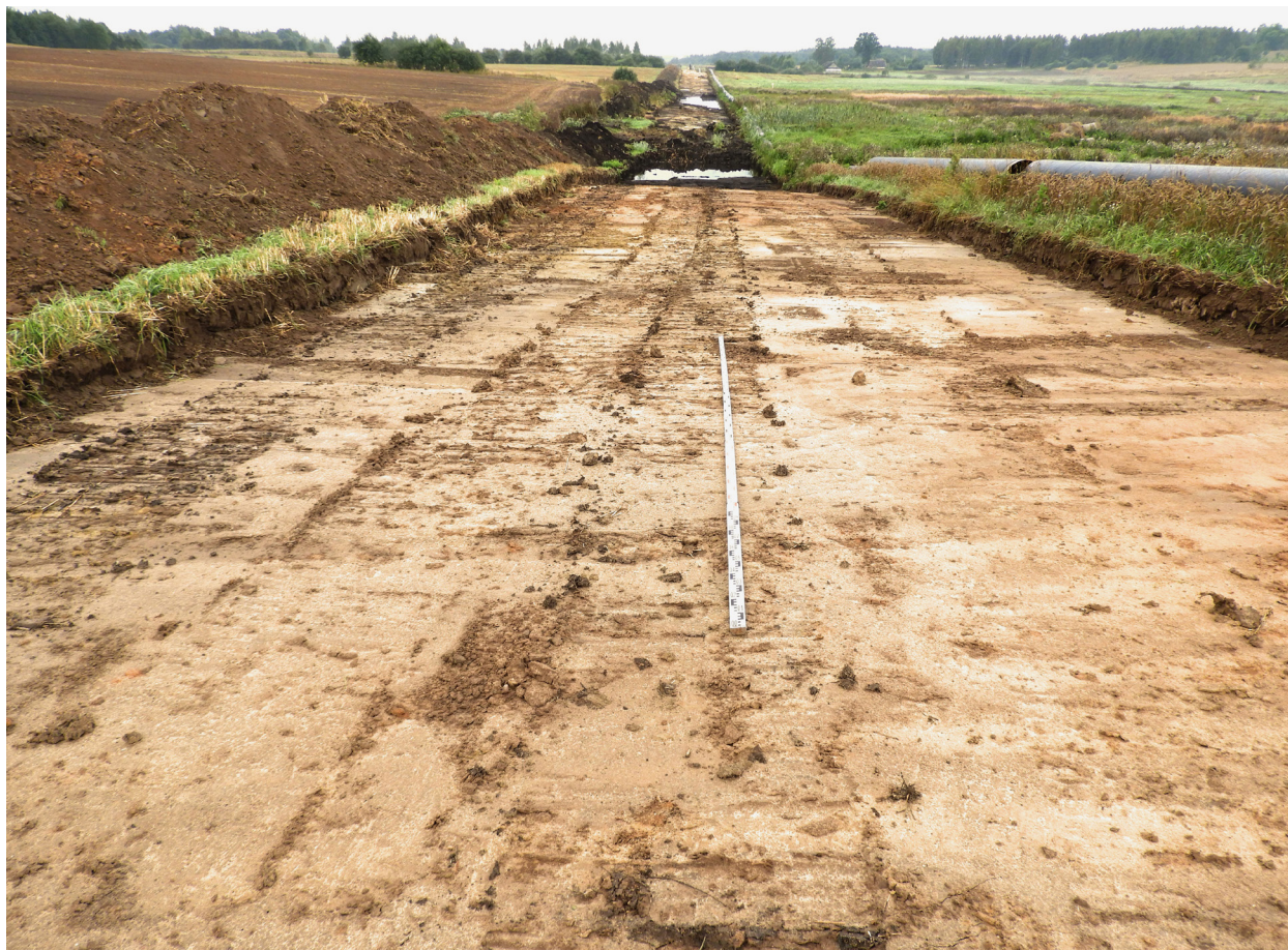
2 pav. Dujotiekio trasos nusileidimas į senosios ežervietės šiaurinę dalį. Vaizdas iš šiaurės rytų pusės. E. Šatavičiaus nuotr. Fig. 2. The descent of the gas pipeline route into the northern part of the paleolake. View from the northeast side. Photo by E. Šatavičius.
